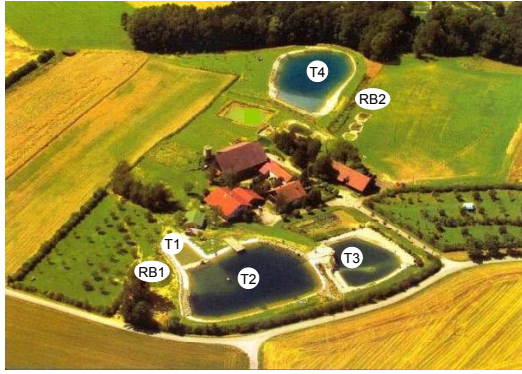
Abb. 2. Luftbildaufnahme der Schwimmteichanlage mit den Teichen T1 bis T4 und Retentionsbecken RB 1 und RB 2 (Stand: Juli 2005).
